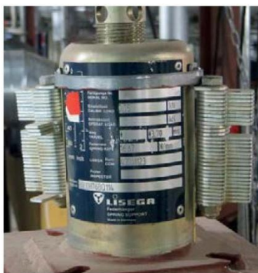
Typ 29 med upphängda säkringar
